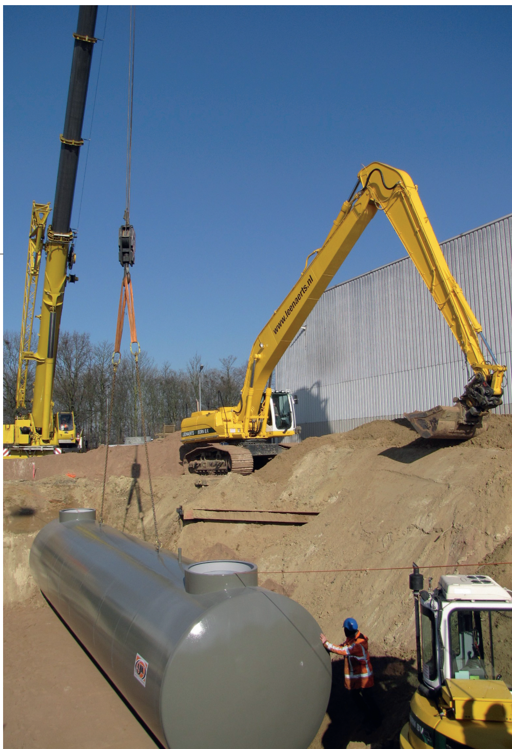
Hamer Installatietechniek is al jaren gespecialiseerd in de aanleg van tankinstallaties en de bouw van complete turnkey tankstations.
